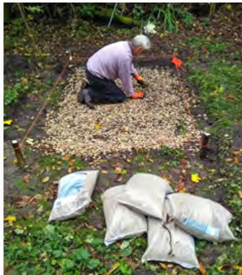
Het maken van de fundering van een observatiehut
